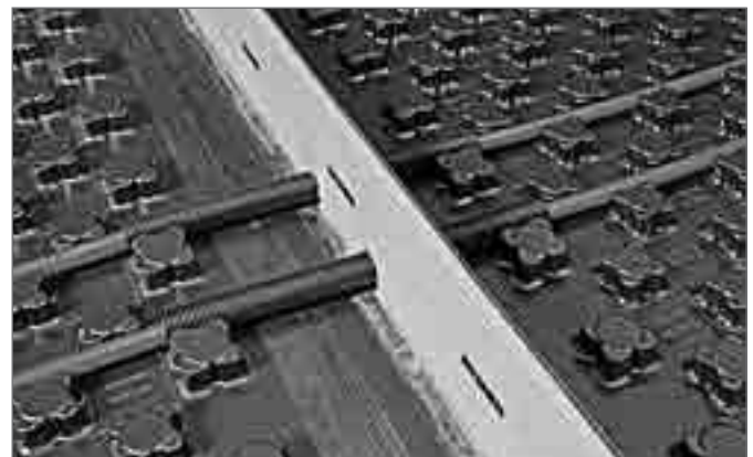
Рис. 16-29 Полосы примыкания и профиль деформационного шва
