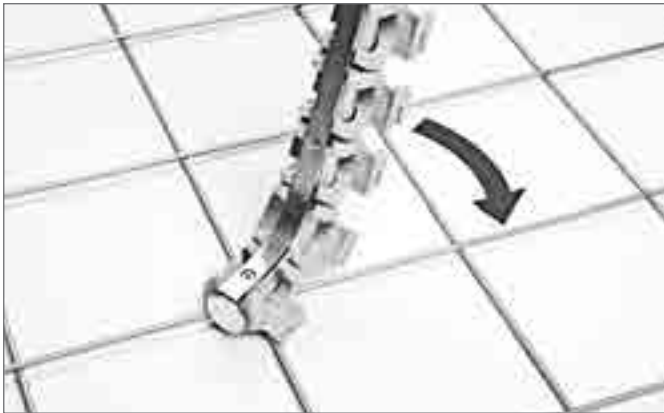
Рис. 16-62 Закрепить поворотную клипсу вращательным движением
