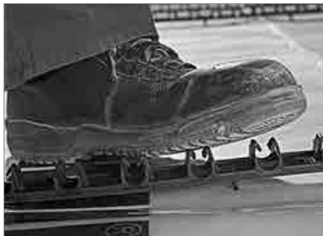
Рис. 16-46 Вдавливание фиксирующих шин RAUFIX в конструкцию пола
